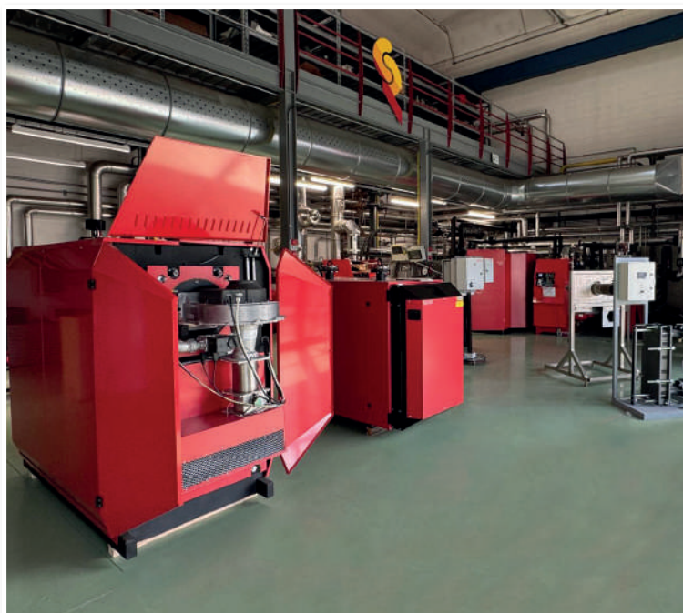
Prove tecniche ns. sala prove
