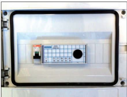
Telecontrollo installato nel quadro elettrico PVC in prossimità regolazione elettronica (per caldaie SERIE CND – 3GF)
